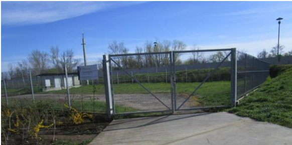
A Kossuth Lajos üdülőparton található csapadékvíz áttemelő
