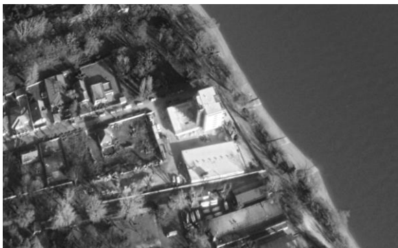
A régi Postás üdülő felújítás után
