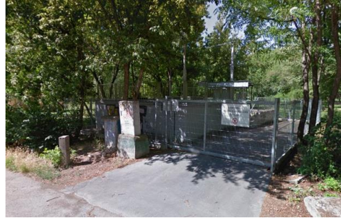
Szennyvízátemelő az Óbudai sziget északi részén
