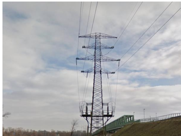
ELMŰ 120 kV-os légvezetékes hálózat rácsos tartóoszlopa a Pók utcánál (forrás: maps.google.com)
