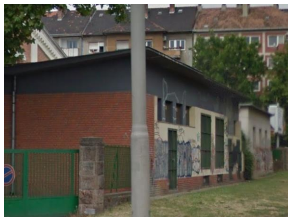
0148-as és 2360-as sz. épületben elhelyezett 10/0,4 kV-os transzformátorok a Dereglye utcában (forrás: maps.google.com)
