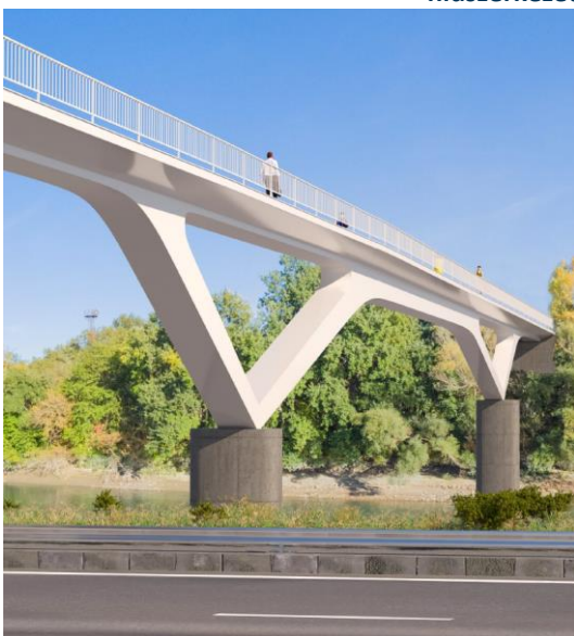
A tervezett négytámaszú acél gerendahíd látványterve forrás: Waterfront City – Óbudai-sziget gyalogos kerethíd Tanulmányterv | SpeciálTerv Kft. (2023)
