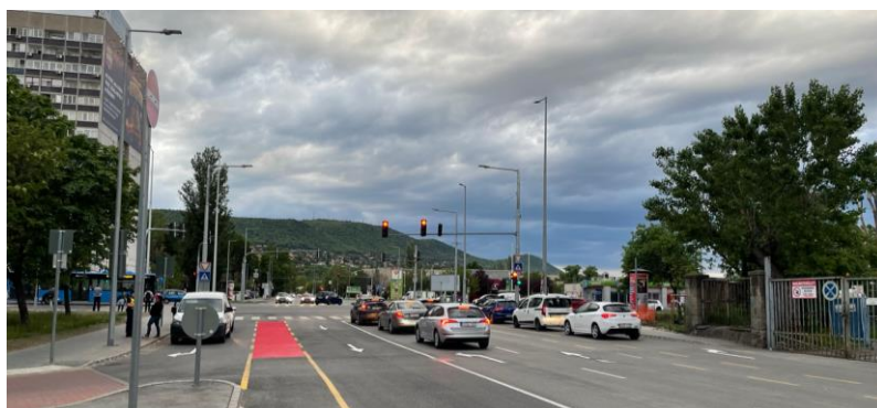
Felbővített Bogdáni úti csomópont nyugati irányba, a Hármashatár-hegy felé tekintve forrás: saját fotó
