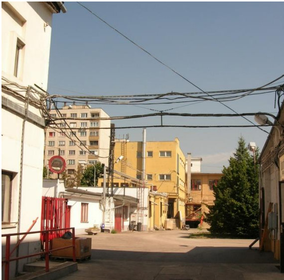
A korábbi trafóház és villanyszerelő műhely (bal oldalt az üdítőital üzem) forrás: saját fotó
