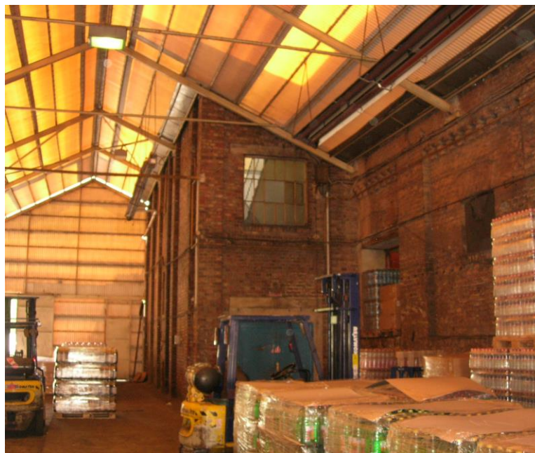
A korábban az épületek között elhelyezkedő fedett raktár forrás: saját fotó
