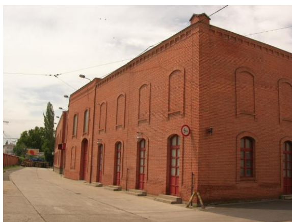
A terület dél-keleti oldalának beépítése, a készáru raktár forrás: saját fotó
